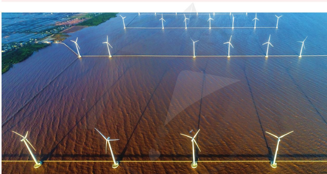
Hình 3.11. Các tua bin gió ở tỉnh Bạc Liêu
